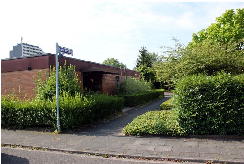
Wohnhäuser am Franz-Stock-Weg in der Konrad-Adenauer-Siedlung in Köln-Neubrück (2015).
