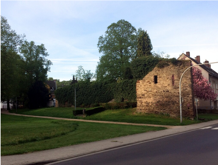
Erhaltene Reste der Sinziger Stadtbefestigung (2018) Fotograf/Urheber: Elmar Knieps
