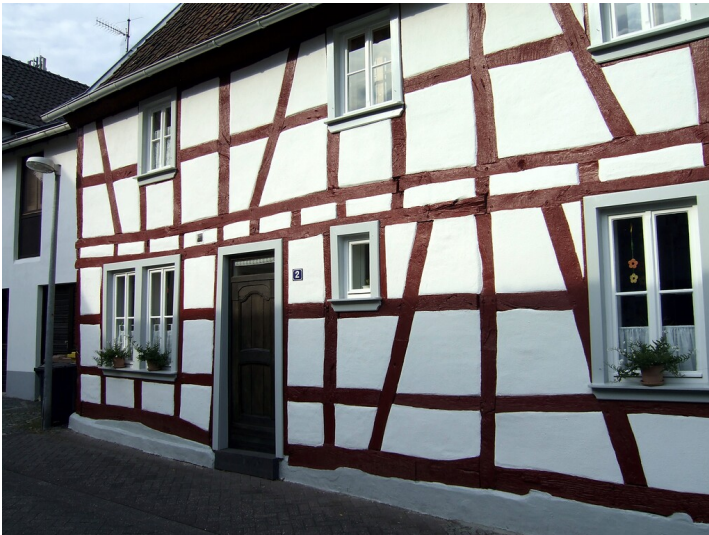
Fachwerkhaus Eulengasse 2 in Sinzig (2013) Fotograf/Urheber: Hans D. Jüchtern
