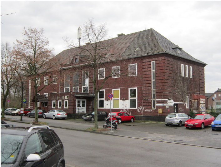
Bahnhof Trompet in Duisburg, Neustraße (2015), Empfangsgebäude, Blick von Südwesten Fotograf/Urheber: Claus Weber
