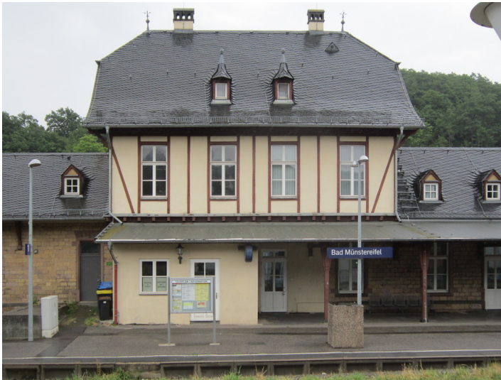
Bahnhof Bad Münstereifel, Empfangsgebäude (2015) Fotograf/Urheber: Claus Weber
