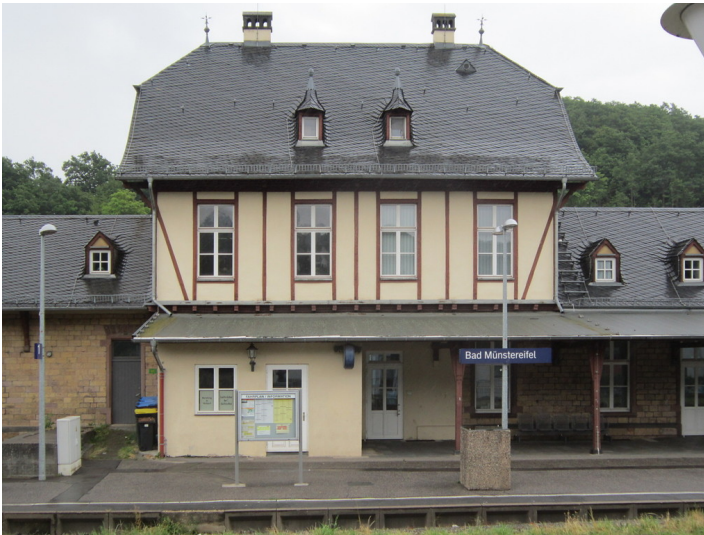
Bahnhof Bad Münstereifel, Empfangsgebäude (2015) Fotograf/Urheber: Claus Weber
