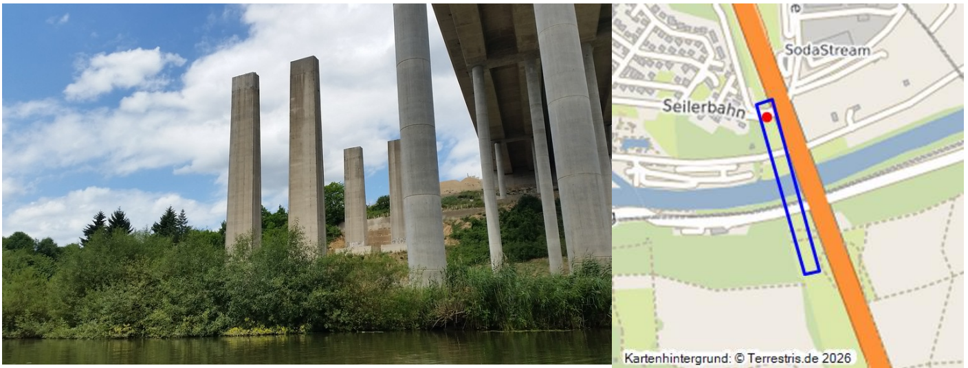
Links sind Pfeiler der abgetragenen Brücke, rechts die neu gebaute Autobahnbrücke bei Limburg zu erkennen (2017). Fotograf/Urheber: Stefanie Cole
