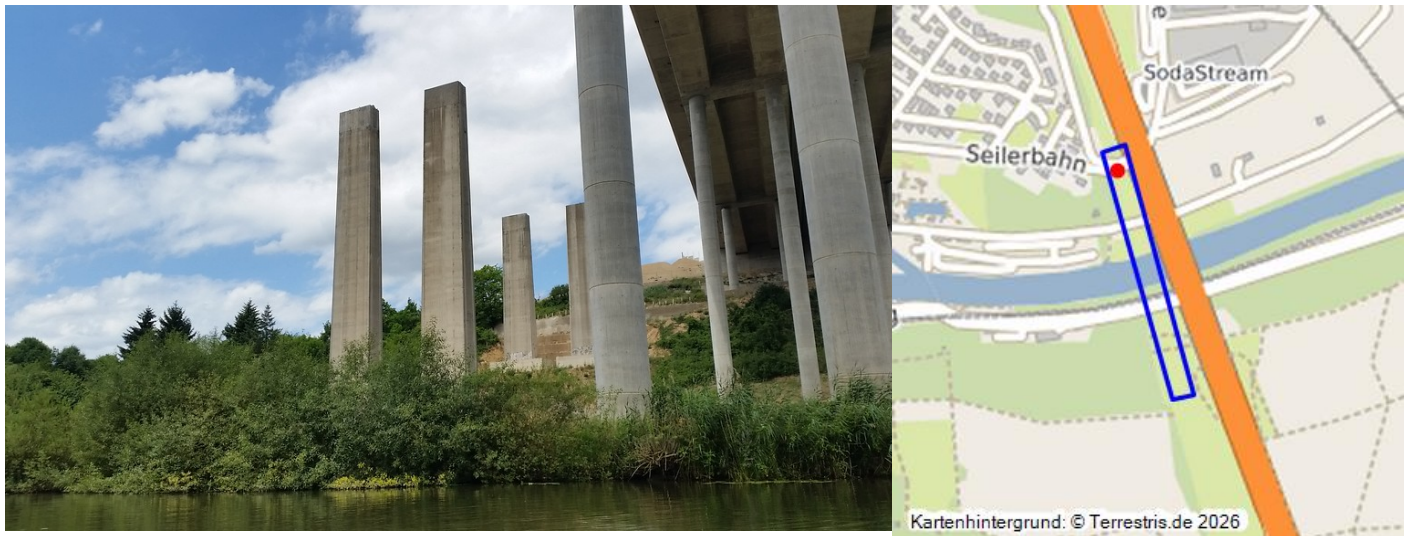
Links sind Pfeiler der abgetragenen Brücke, rechts die neu gebaute Autobahnbrücke bei Limburg zu erkennen (2017). Fotograf/Urheber: Stefanie Cole
