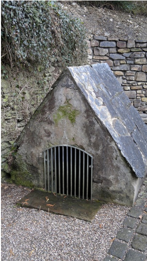
Brunnenhäusschen am Simonsbrunnen in Sayn (2015) Fotograf/Urheber: Milena Bagic
