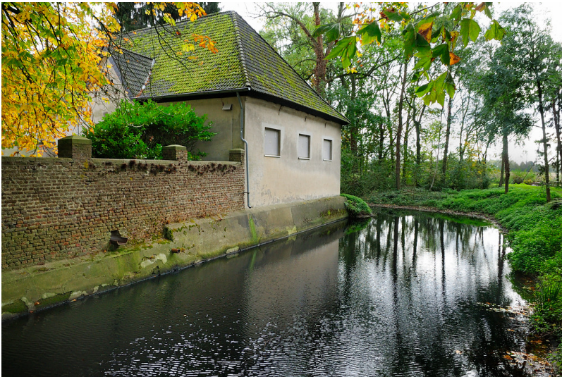
Ansicht des von einem Wassergraben umgebenen Haus Horr in Grevenbroich (2014) Fotograf/Urheber: Hans-Georg Wende
