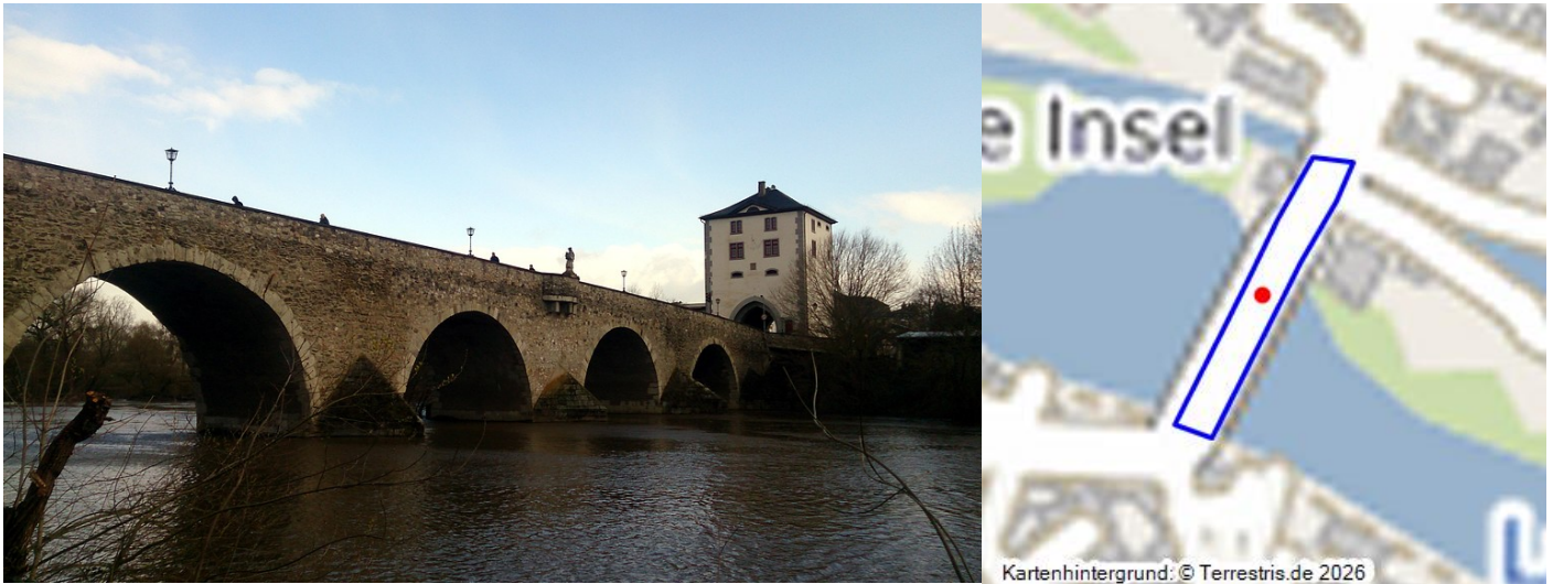
Die Alte Lahnbrücke in Limburg an der Lahn (2015). Fotograf/Urheber: Euteneuer, Jana
