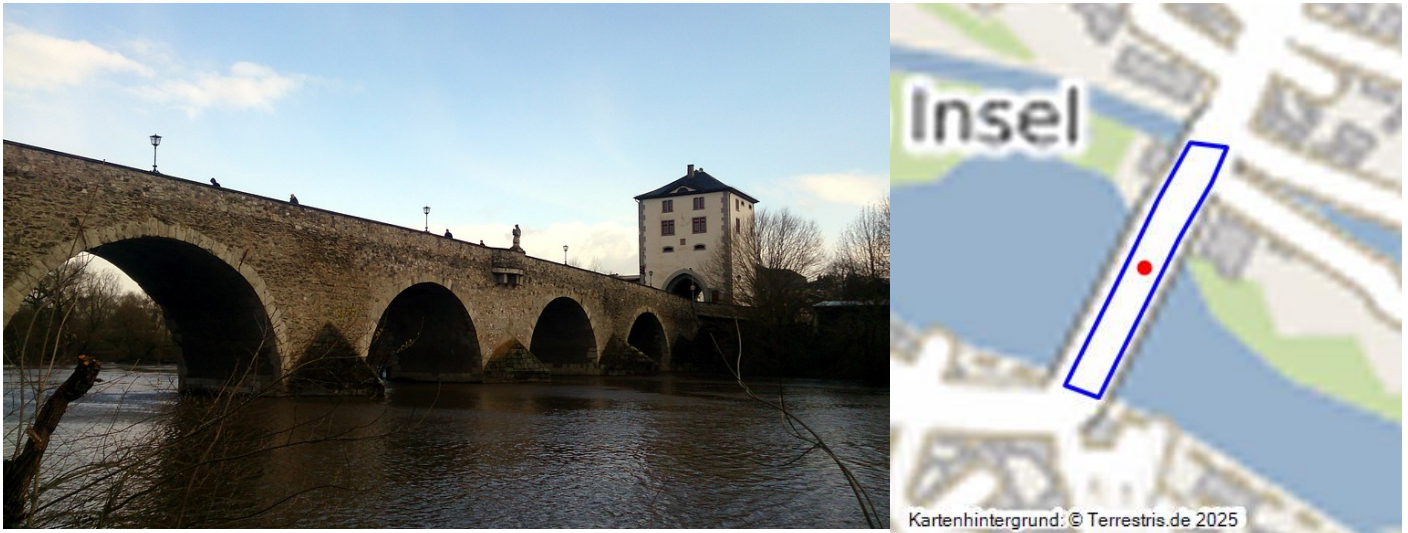
Die Alte Lahnbrücke in Limburg an der Lahn (2015). Fotograf/Urheber: Euteneuer, Jana
