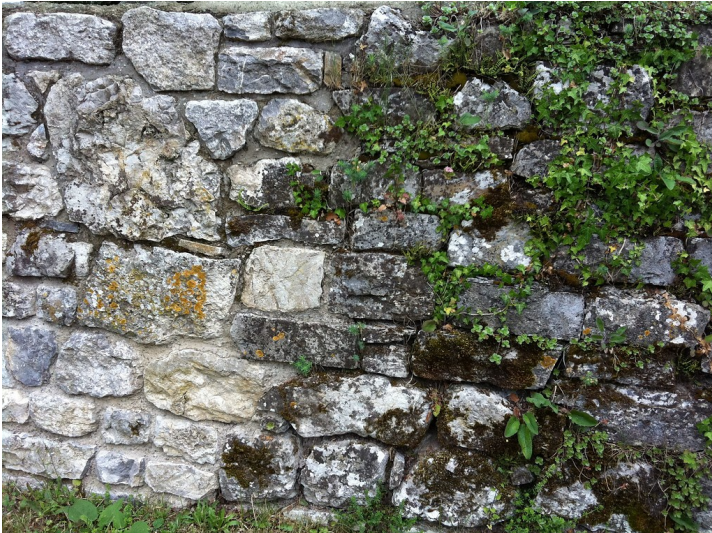
Bruchsteinmauer am Kirchhof Sand. Links vermörteltes, rechts offenfugiger Bereich. Fotograf/Urheber: Hentrich, Anne
