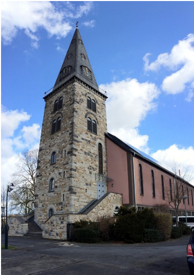
Die 1953 erbaute Evangelische "Christuskirche" in Altenkirchen (2015) Fotograf/Urheber: Nina Hassel
