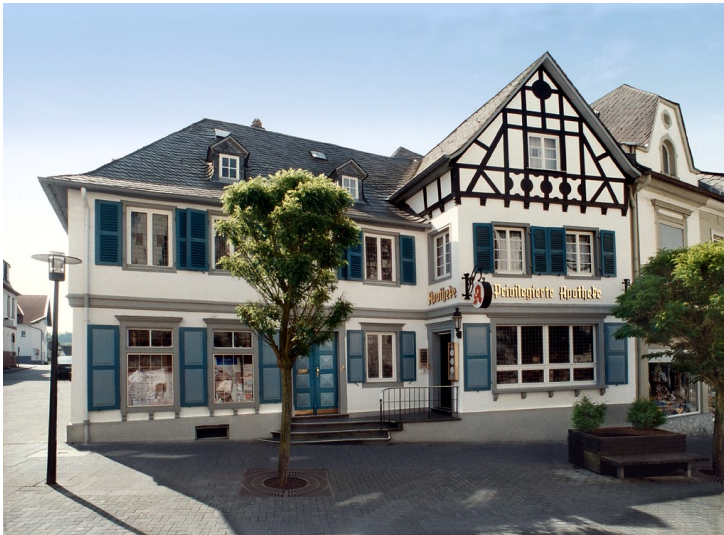
Das Gebäude der "Privilegierten Apotheke" in Altenkirchen (2015) Fotograf/Urheber: Nina Hassel
