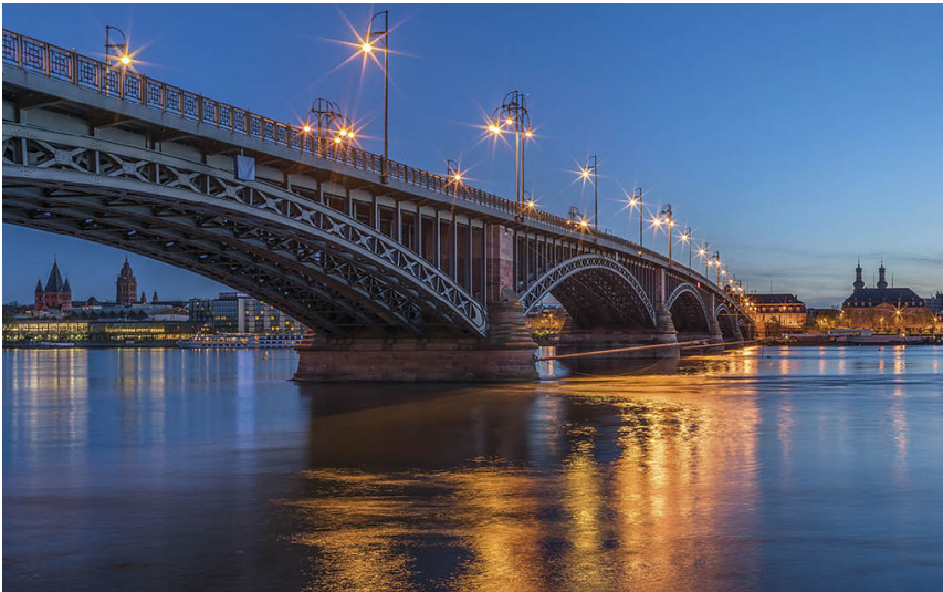
Theodor-Heuss-Brücke in Mainz (2019) Fotograf/Urheber: Holger Klaes
