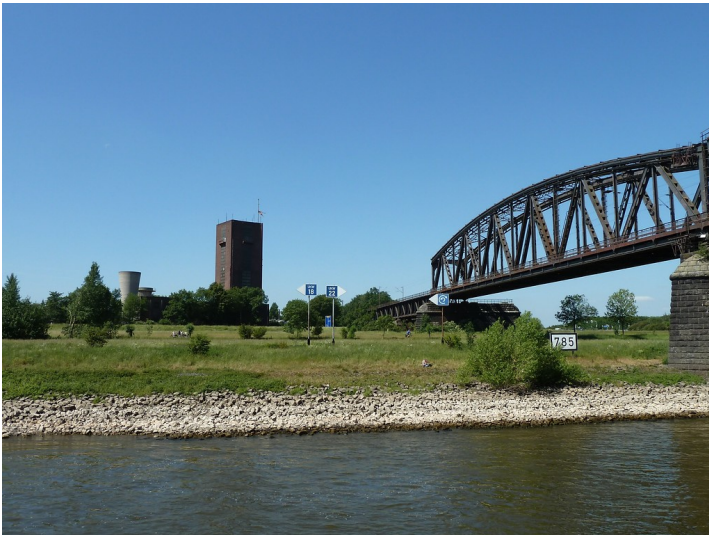
Wetterschacht "Gerdt" der Schachanlage Rheinpreußen 8 in Duisburg (2011) Fotograf/Urheber: Kai-William Boldt
