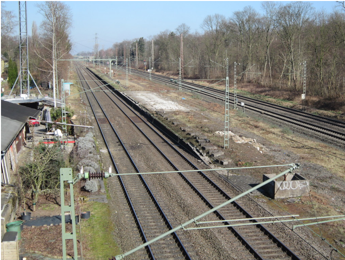
Bahnhof Kalkum in Düsseldorf, Blick über den ehemaligen Mittelbahnsteig nach Norden. Rechts die beiden Schnellfahrgeleise ohne Bahnsteig (2015). Fotograf/Urheber: Claus Weber
