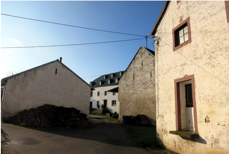
Ältere und für den historischen Weiler typische Wohn- und Hofgebäude in Bitburg-Irsch (2015) Fotograf/Urheber: Cali Burton
