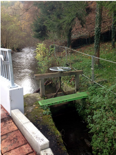
Die Schleusenmechanik am Mühlenbach nahe der Heinsmühle im Brexbachtal bei Sayn (2014). Fotograf/Urheber: Karolina Paus
