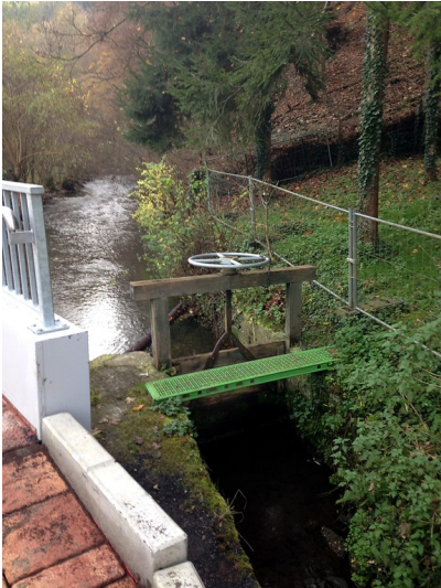
Die Schleusenmechanik am Mühlenbach nahe der Heinsmühle im Brexbachtal bei Sayn (2014). Fotograf/Urheber: Karolina Paus
