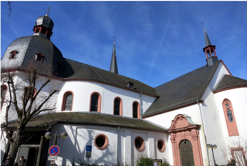
Die älteste Kirche Bitburgs, die Pfarrkirche Liebfrauen (2015) Fotograf/Urheber: Cali Burton
