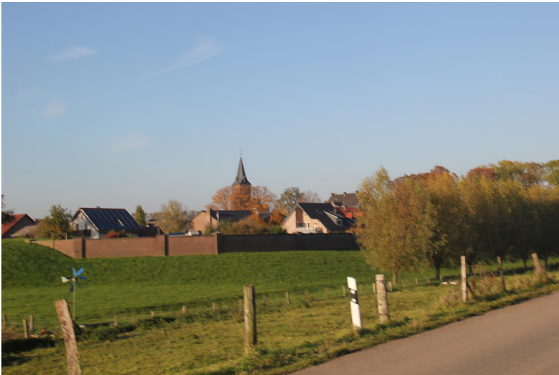
Die heutige Ortschaft Kleve-Schenkenschanz mit der Hochwasserschutzmauer (2015). Fotograf/Urheber: Peter Burggraaff
