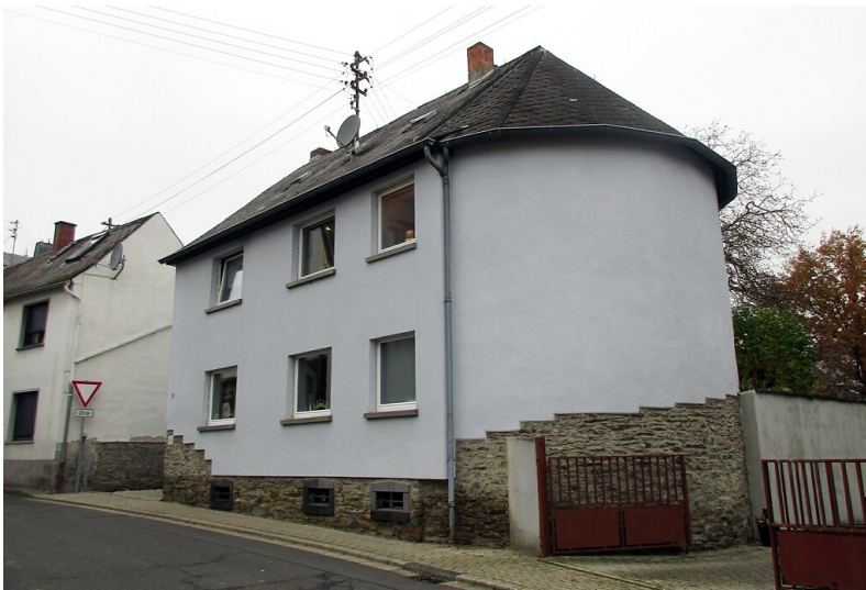
Das einstige Synagogengebäude in Mertloch, das heute nach einem Umbau als Wohnhaus genutzt wird (2022). Fotograf/Urheber: Franz-Josef Knöchel
