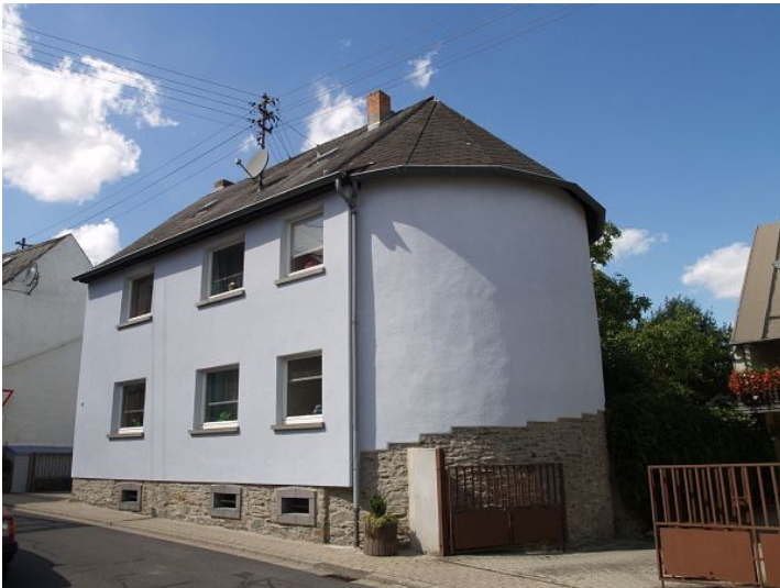
Das heute als Wohnhaus genutzte Gebäude der Synagoge in Mertloch (2009).
