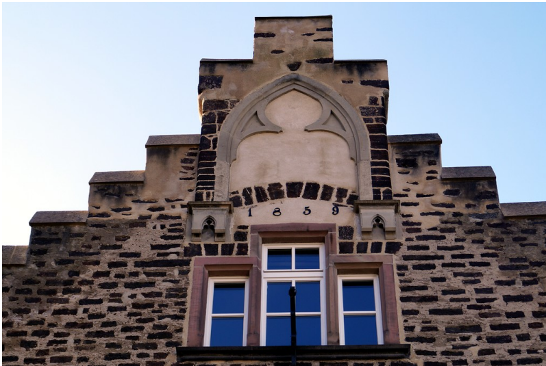
Der Giebel des Rathauses am Marktplatz in Polch (2015); gut zu erkennen ist die Jahreszahl des Baus 1859. Fotograf/Urheber: Abels, Jennifer
