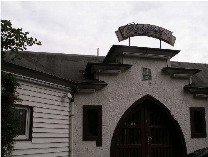
Freibad Herrenstrunden - Eingangsgebäude Fotograf/Urheber: Hentrich, Anne
