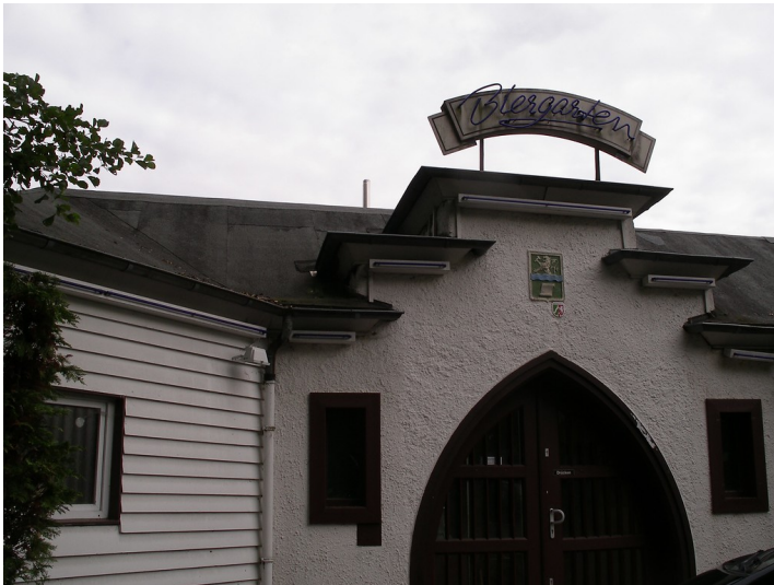
Freibad Herrenstrunden - Eingangsgebäude Fotograf/Urheber: Hentrich, Anne
