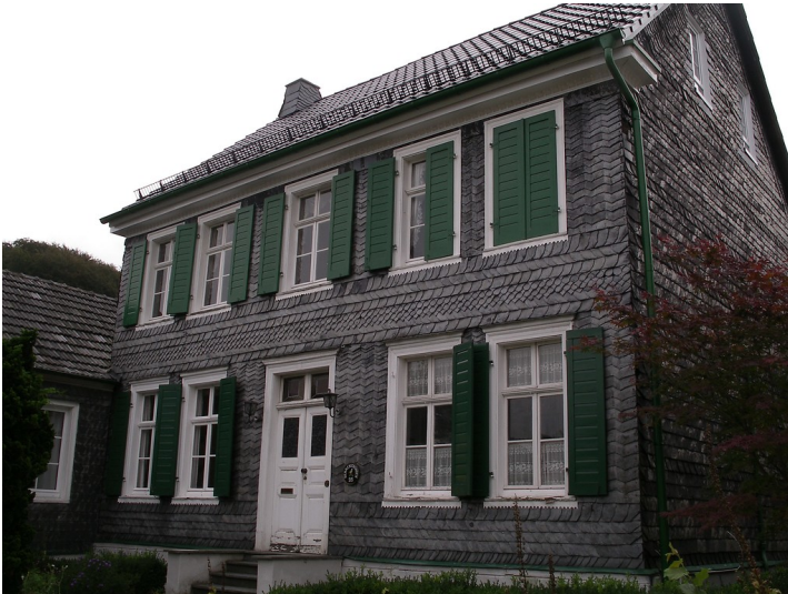
Das Alte Pfarrhaus in Herrenstrunden (2004) Fotograf/Urheber: Hentrich, Anne
