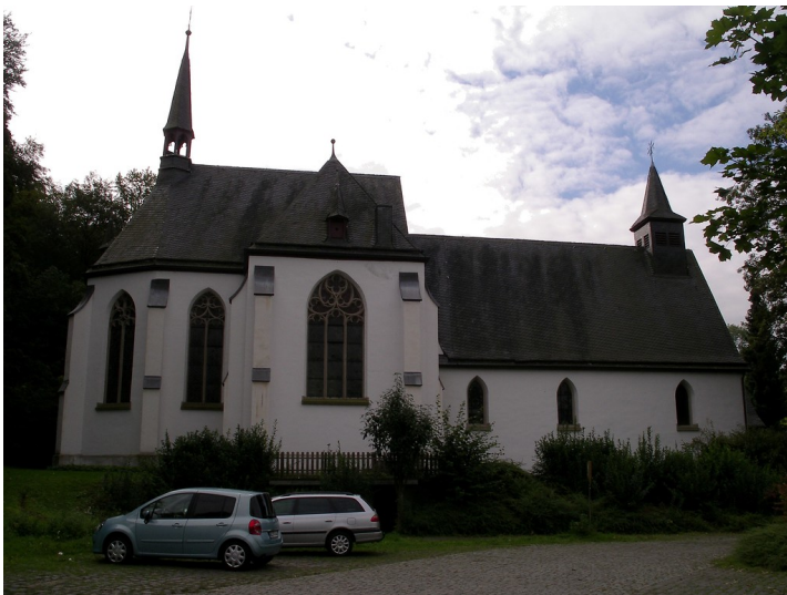
St. Johannes der Täufer Fotograf/Urheber: Hentrich, Anne
