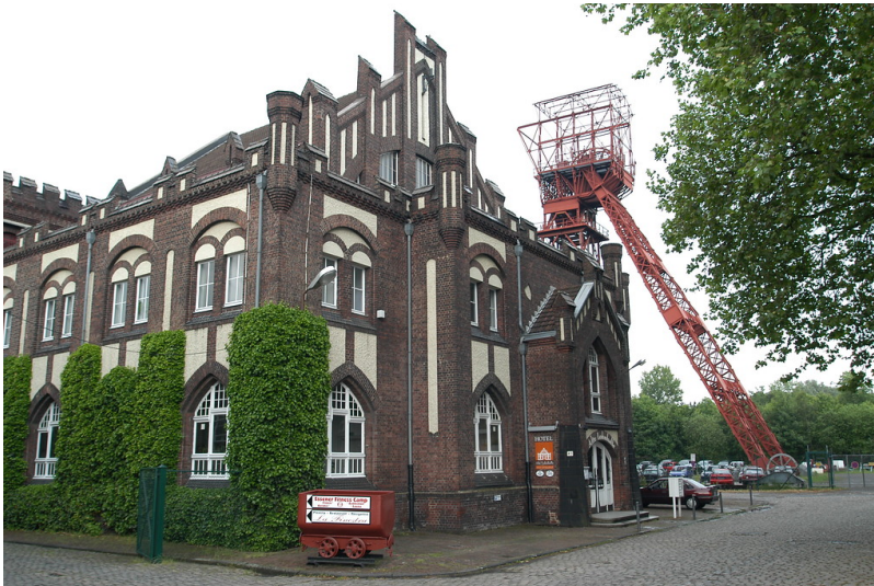
Gebäudeensemble der Zeche Bonifacius 2 (2004) Fotograf/Urheber: Kai-William Boldt
