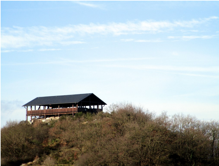
Der Schutzbau über den Mauerresten der spätromischen Befestigung "Römerwarte Katzenberg" bei Mayen, Ansicht vom Parkplatz aus (2015) Fotograf/Urheber: Gasper, Anne
