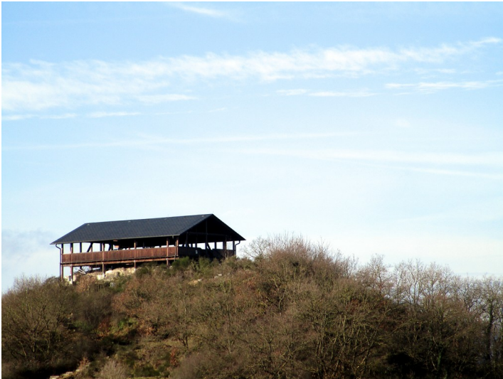
Der Schutzbau über den Mauerresten der spätromischen Befestigung "Römerwarte Katzenberg" bei Mayen, Ansicht vom Parkplatz aus (2015) Fotograf/Urheber: Gasper, Anne
