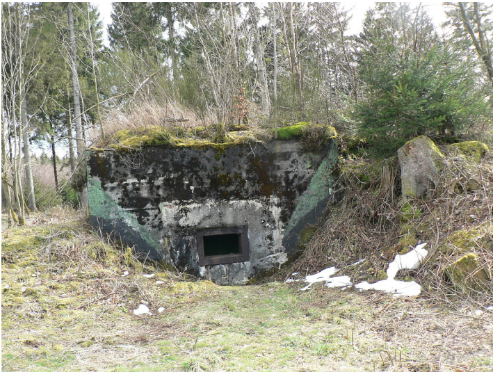
Blick in einen Bunkerhof eines Unterstandes vom Typ 10 mit angehängtem Kampfstand von 1938, zu sehen ist die Schießscharte des angehängten Kampfstandes (2008). Fotograf/Urheber: Müssemeier, Ulrike
