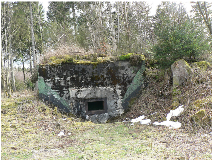
Blick in einen Bunkerhof eines Unterstandes vom Typ 10 mit angehängtem Kampfstand von 1938, zu sehen ist die Schießscharte des angehängten Kampfstandes (2008). Fotograf/Urheber: Mússemeier, Ulrike
