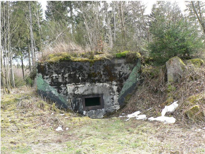
Blick in einen Bunkerhof eines Unterstandes vom Typ 10 mit angehängtem Kampfstand von 1938, zu sehen ist die Schießscharte des angehängten Kampfstandes (2008). Fotograf/Urheber: Mússemeier, Ulrike
