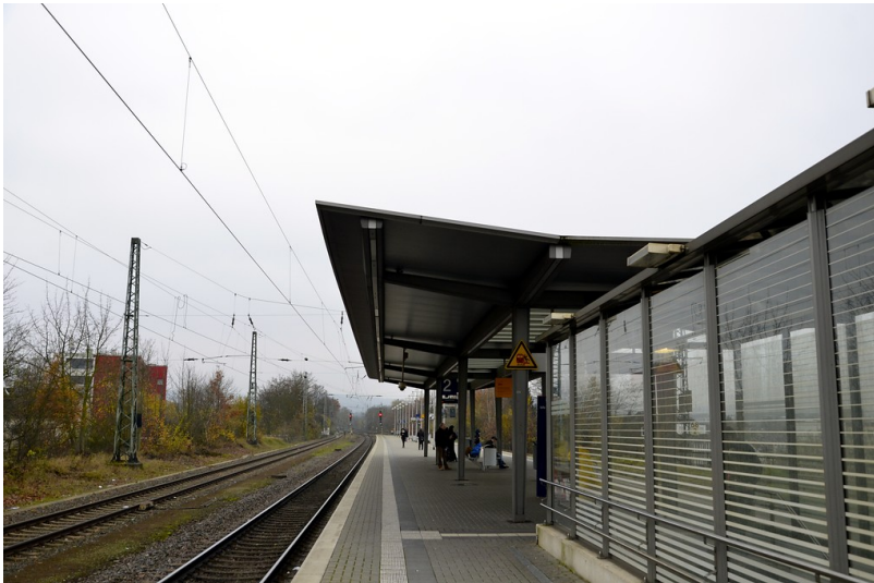
Bahnsteig und Gleiskörper am Bahnhof Rothe Erde in Aachen (2014) Fotograf/Urheber: Leblebici, Suzan
