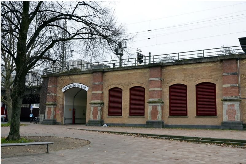
Empfangsgebäude des Bahnhofs Rothe Erde in Aachen (2014), Zugang Beverstraße Fotograf/Urheber: Leblebici, Suzan
