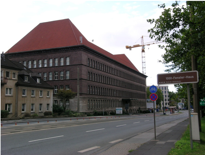
Tausendfensterhaus (Haus Ruhrort) in Duisburg-Ruhrort (2005) Fotograf/Urheber: Kai-William Boldt
