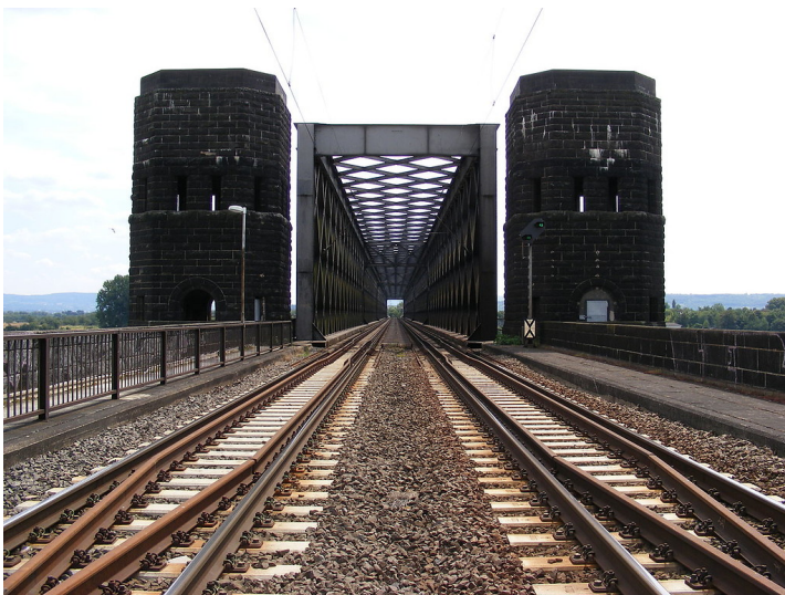
Einfahrt in die Eisenbahnbrücke "Kronprinz-Wilhelm-Brücke" bei Neuwied (2009). Fotograf/Urheber: Miriam Lux
