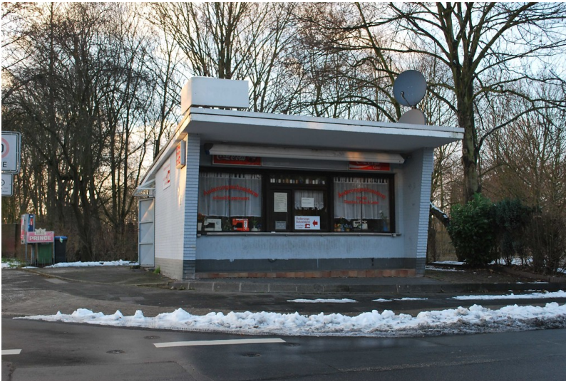
Trinkhalle an der Waldstraße/Hans-Böckler-Straße in Neukirchen-Vluyn (2014) Fotograf/Urheber: Kai-William Boldt
