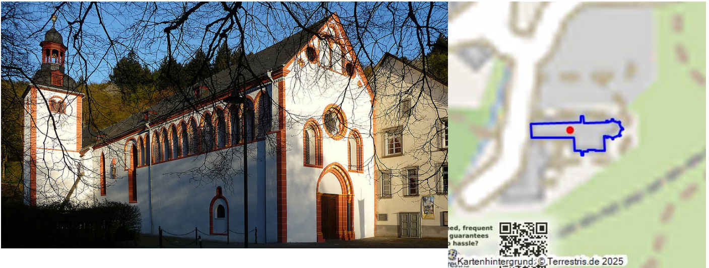
Die Abteikirche Sayn nach der Renovierung 2015, Nordseite und Westfront (2016) Fotograf/Urheber: ECAP 1718
