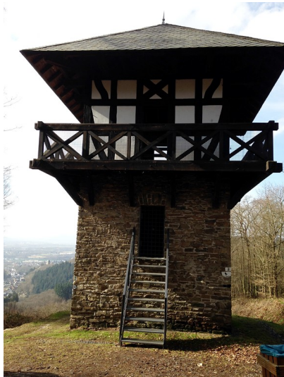
Der rekonstruierte Limesturm WP 1/54 in Sayn aus östlicher Richtung (2015).
