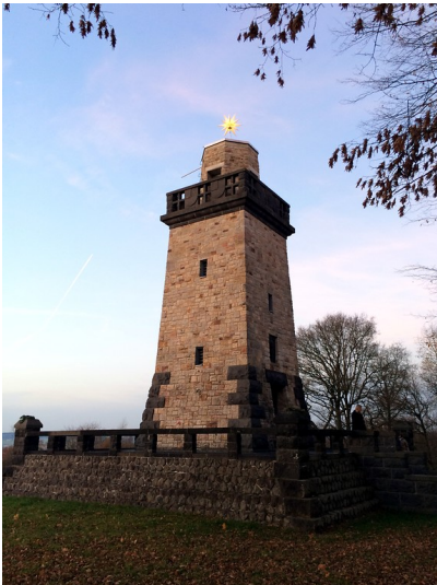
Der Bismarckturm "Auf dem Dorn" in Altenkirchen im Westerwald (2014). Fotograf/Urheber: Hassel, Nina
