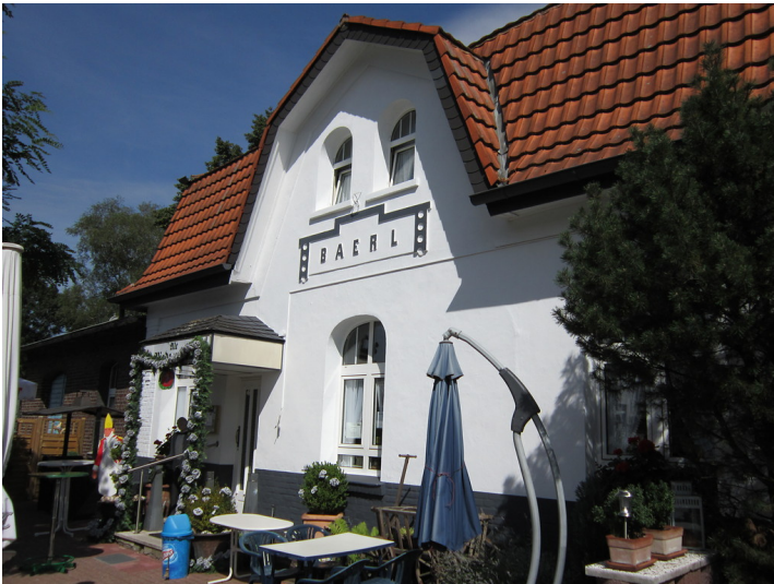
Empfangsgebäude im Kreisbahnhof Baerl, Gleisseite (2012) Fotograf/Urheber: Claus Weber
