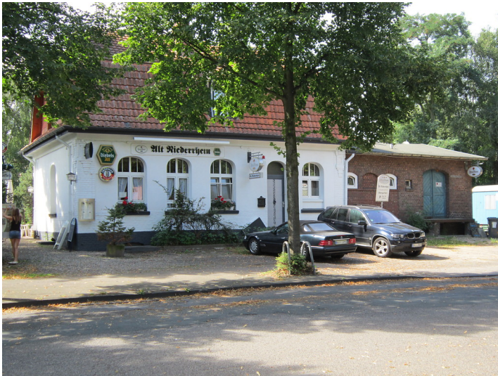
Empfangsgebäude im Kreisbahnhof Baerl, Straßenseite (2012) Fotograf/Urheber: Claus Weber
