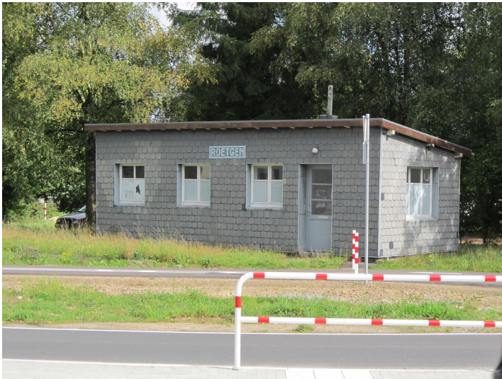
Empfangsgebäude des ehemaligen Bahnhofs Roetgen an der Vennbahn (2011) Fotograf/Urheber: Claus Weber
