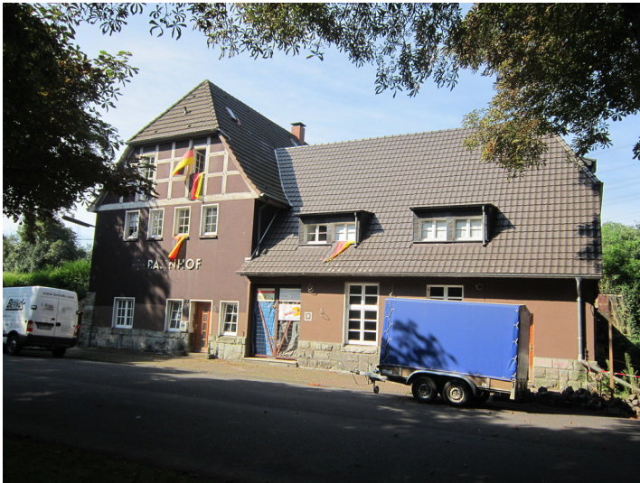
Empfangsgebäude im Bahnhof Walsum, Straßenseite (2014) Fotograf/Urheber: Claus Weber
