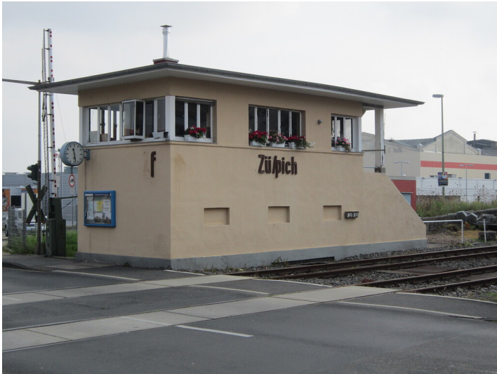
Bahnhof Zülpich, Stellwerk Zf, Ansicht aus Süden (2014) Fotograf/Urheber: Claus Weber
