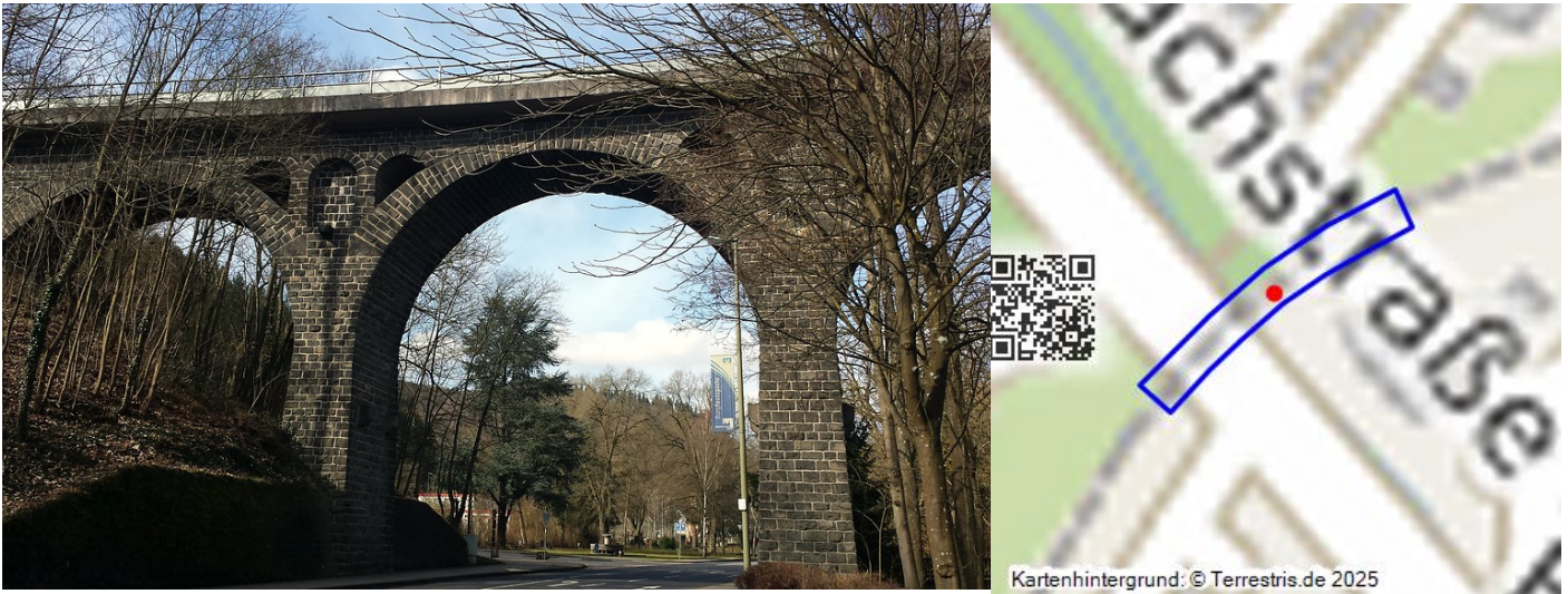
Das Eisenbahnviadukt über die Nette, Büresheimerstraße in Mayen (2015) Fotograf/Urheber: Gasper, Anne
