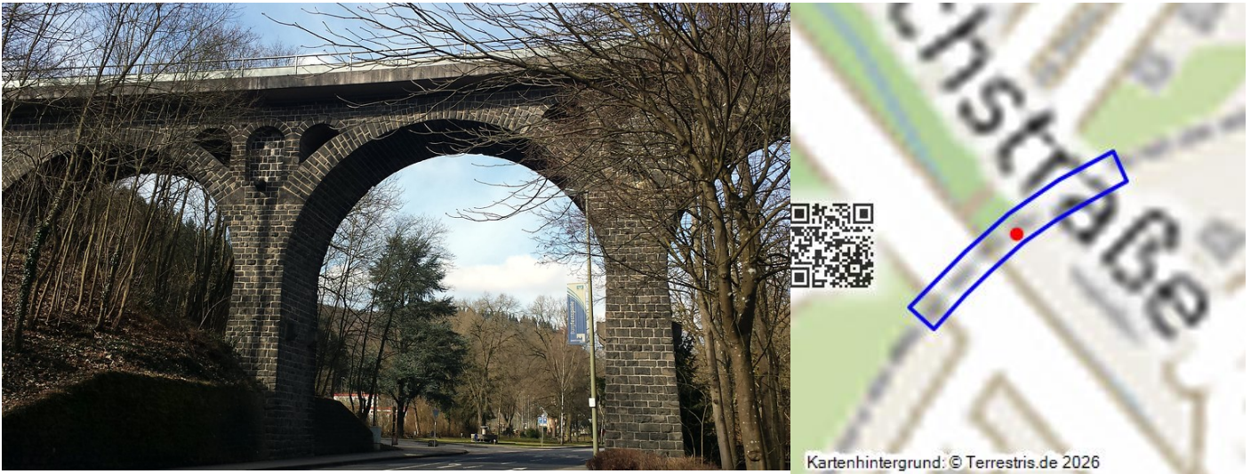
Das Eisenbahnviadukt über die Nette, Bürresheimerstraße in Mayen (2015) Fotograf/Urheber: Gasper, Anne
