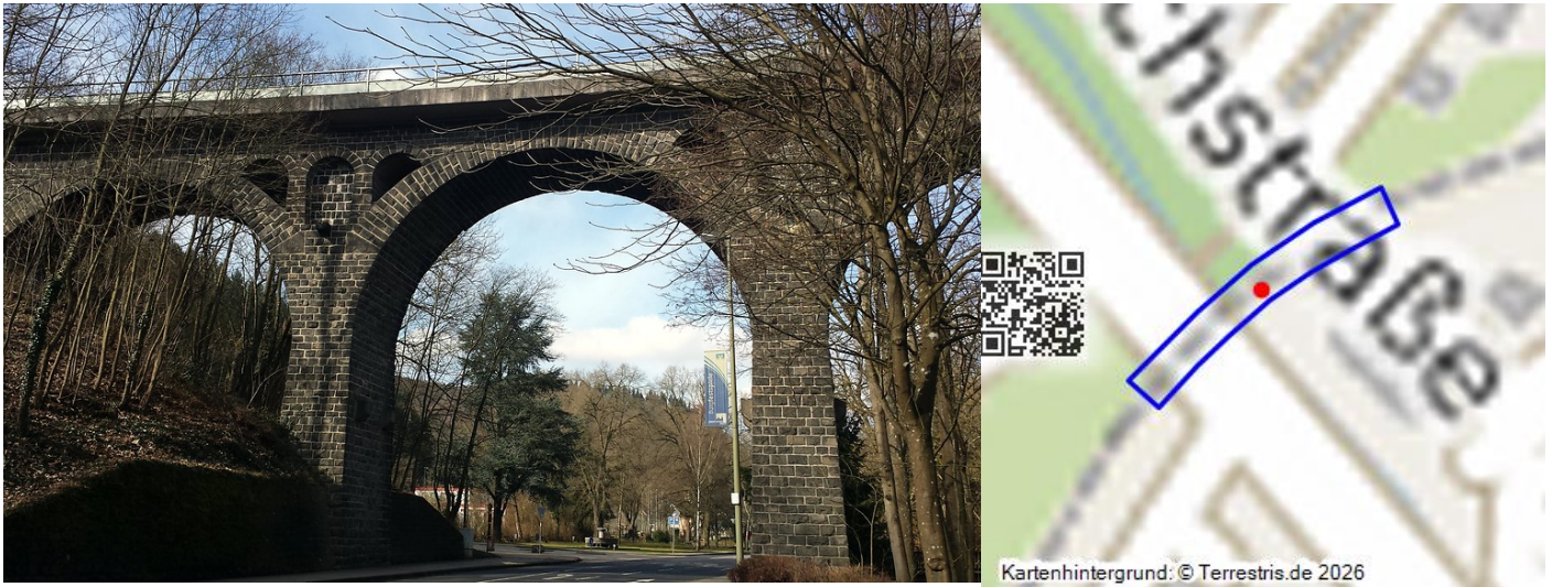
Das Eisenbahnviadukt über die Nette, Bürrsheimerstraße in Mayen (2015) Fotograf/Urheber: Gasper, Anne
