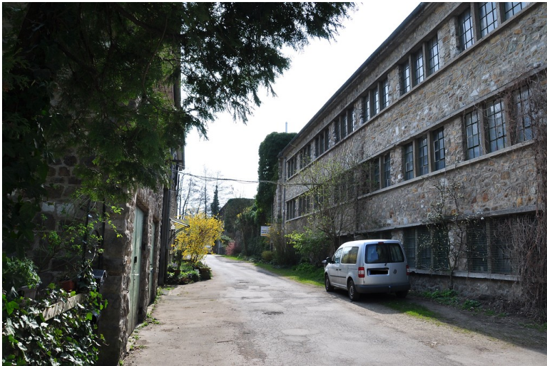
Haumühle - Fabrikgebäude (2014) Fotograf/Urheber: Fine Tonhauser
