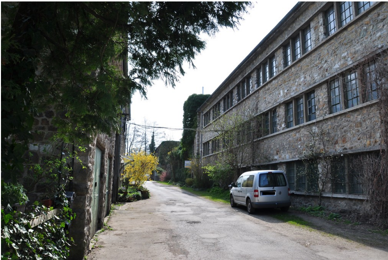
Haumühle - Fabrikgebäude (2014) Fotograf/Urheber: Fine Tonhauser
