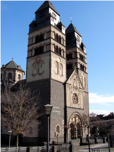
Die westliche Fassade der katholischen Pfarrkirche Herz-Jesu in Mayen (2013). Fotograf/Urheber: Jonas Breithaupt
