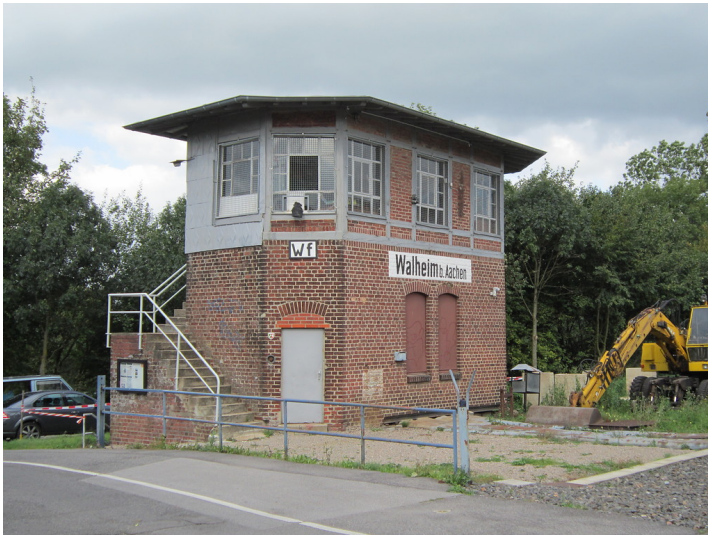
Stellwerk Wf am südwestlichen Ende des Bahnhofes Walheim in Aachen (2011) Fotograf/Urheber: Claus Weber
